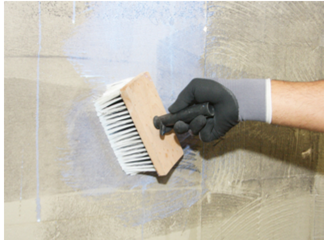
2. Stark und unterschiedlich saugende Untergründe mit Sopro Grundierung vorbehandeln.
