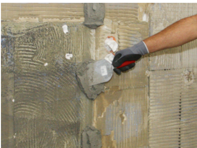
5. Zum späteren Abziehen des Mörtels werden Putzschienen gesetzt. Hierzu zunächst den Putz in Batzen aufbringen ...
