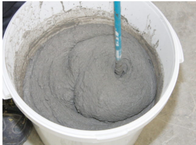
4. Sopro RAP 2® maschinell knollenfrei anmischen. Nach einer Reifezeit von 3 – 5 Minuten erneut durchmischen.
