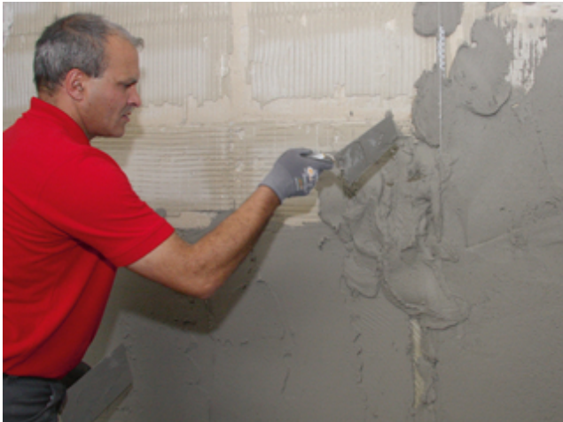
7. Die Fläche zwischen den Putzschienen durch Anwerfen von Sopro RAP 2® mit Putz füllen.
